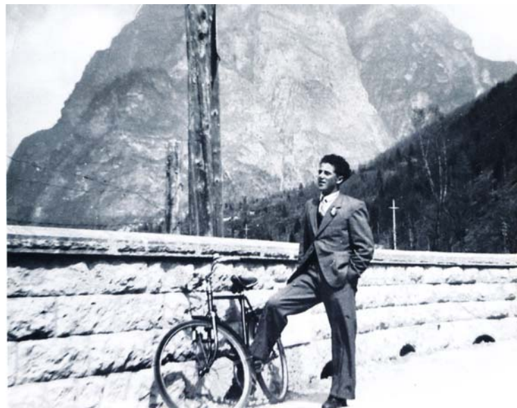
Umberto Brancaleone, allora ventenne, sul coronamento della diga in costruzione di Barcis, con la bicicletta "Botteccia" con cui, nell'autunno del 1953, affrontò il tragitto di 85 km tra Barcis e Taibon per portare in salvo la strana pietra, poi identificata come una meteorite
